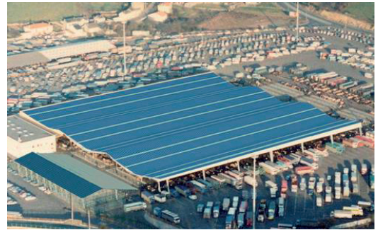
La couverture photovoltaïque du marché aux bestiaux de Parthenay
