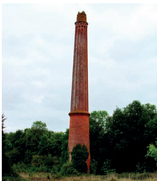
La cheminée du four Hoffmann Coulonges sur l'Autize
